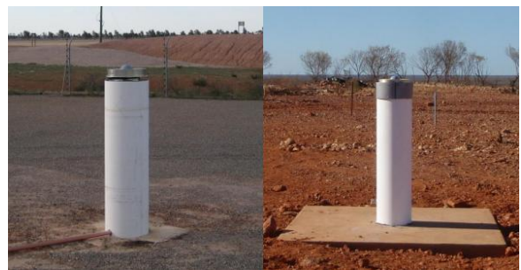
Slika 19 – Primer učvršćivanja Tier 1 i 2 CORS-a za Zemlju
