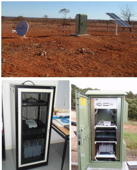
Slika 24 – Solarni način napajanja i baza sa baterijom
