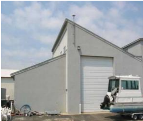
Slika 20 – Antena montirana na zidu
